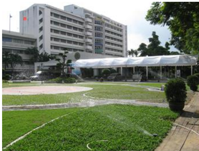
ภาพที่ 4.45 แสดงการทดสอบการทำงานของระบบรดน้ำต้นไม้
