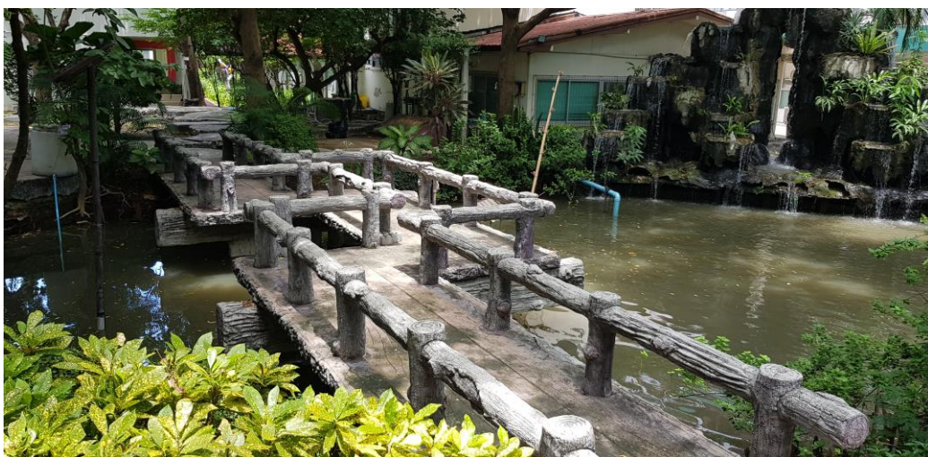
ภาพที่ 3.32 แสดงรูปแบบสะพานแบบซิกแซกข้ามเพื่อเชื่อมทางเดินผ่านสระน้ำ ที่มาภาพประกอบ : อาคารศูนย์สิ่งแวดล้อมศึกษา(อาคาร 9) มหาวิทยาลัยราชภัฏพระนคร
