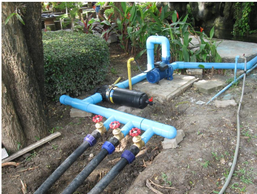
ภาพที่ 4.41 แสดงการดำเนินการวางระบบรดน้ำต้นไม้
