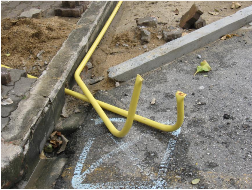
ภาพที่ 4.40 แสดงการดำเนินการวางระบบไฟฟ้าแสงสว่าง
