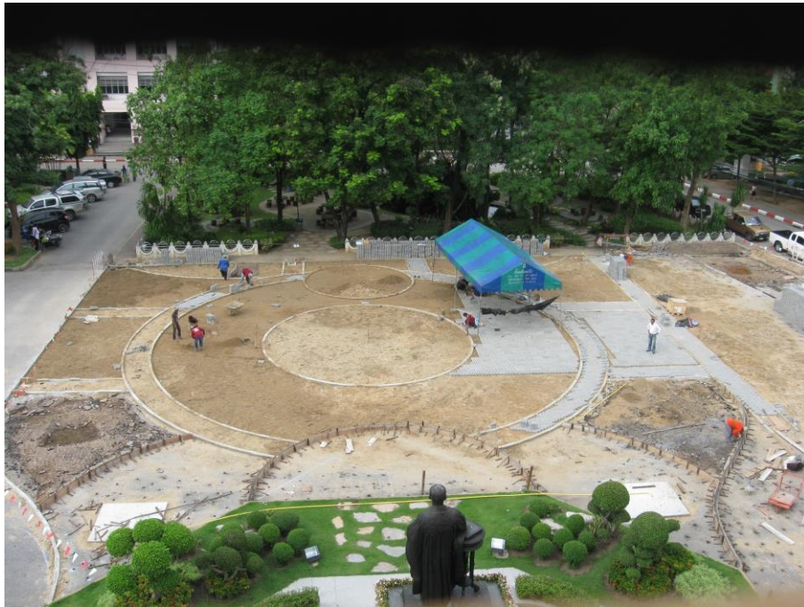
ภาพที่ 4.37 แสดงการดำเนินการจัดทำลานอเนกประสงค์หลังจากที่ได้ตรวจเช็คระยะแล้ว
